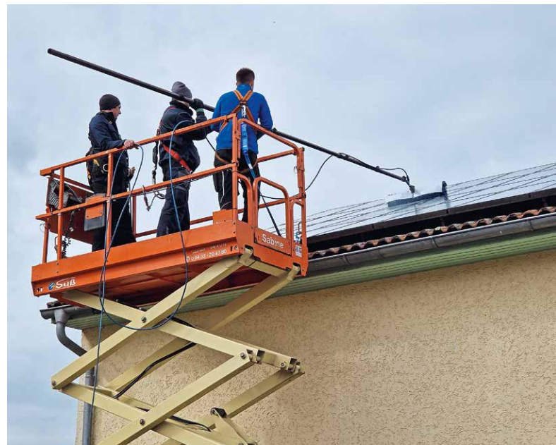
Als günstigster Zeitpunkt für die Reinigung von Photovoltaikmodulen gilt ein regnerischer oder zumindest wolkenverhangener Frühlingstag.
